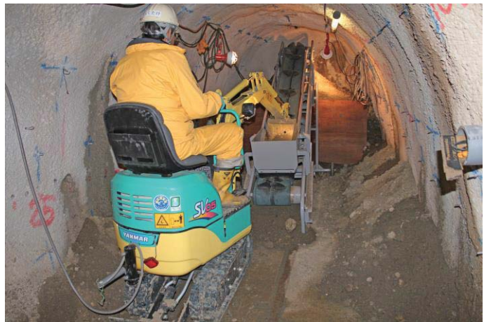
坑道充填作業状況
